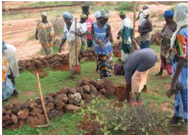
Mobilisation communautaire pour la construction de cordons pierreux, Landou, Mali, 2009.
